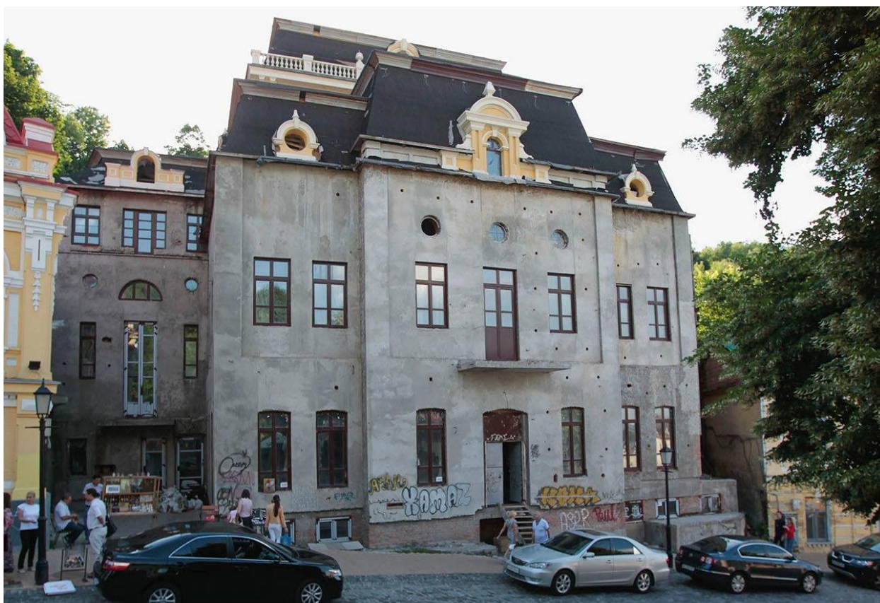
Фото 1.1. Будівля театру до реконструкції, 2015 р. Автор Stepan Stepanov.
